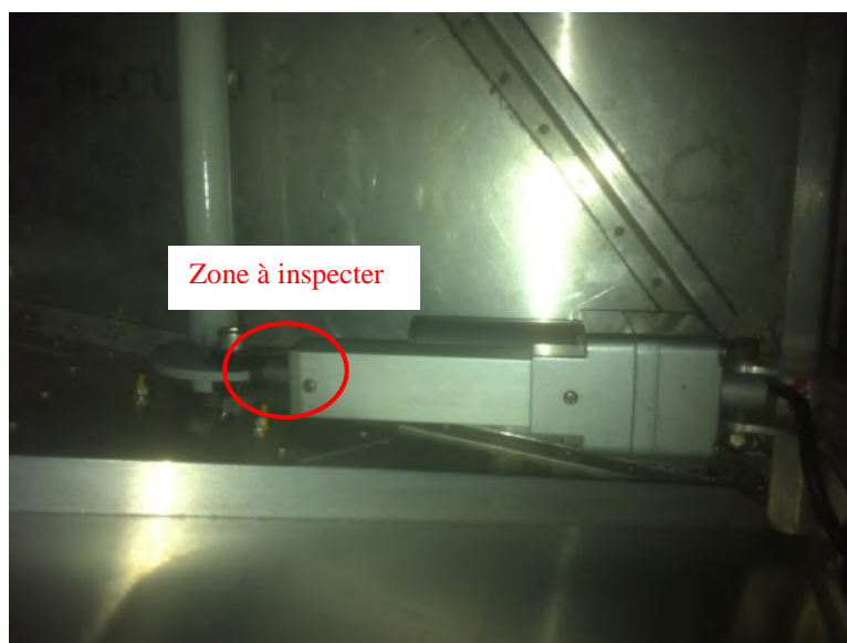
Photo du moteur de volet monté dans l'appareil
